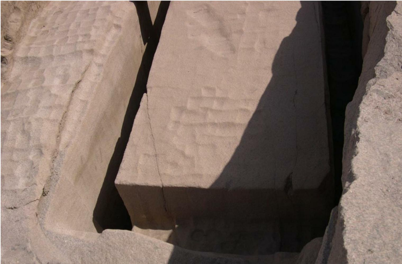
**Рис. 123.** Следы инструмента на Обелиске в асуанских каменоломнях
